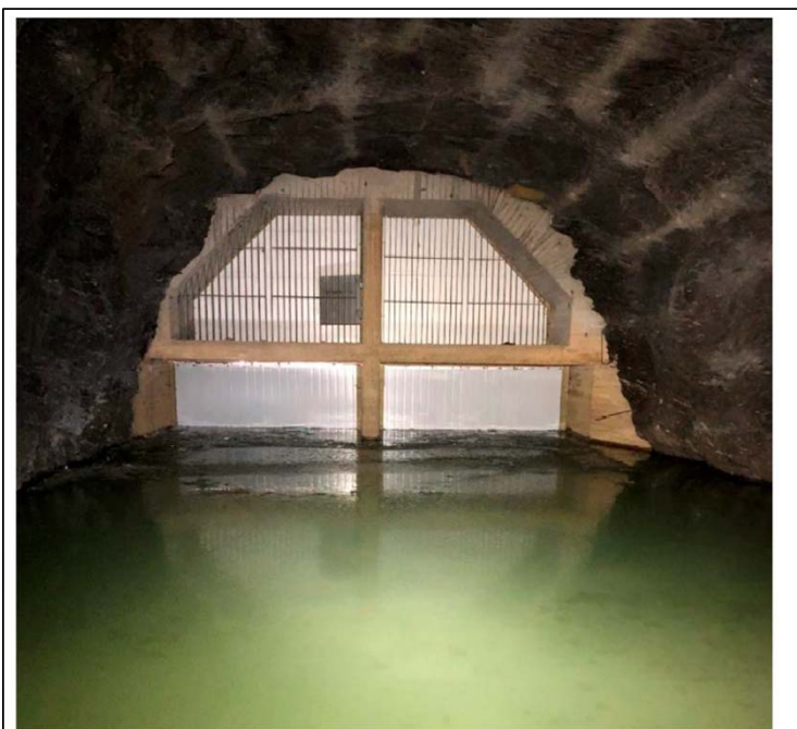
Figur 3 - Inne i isolasjonsluker nedside tunnel
